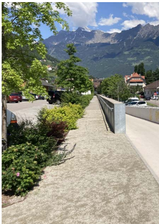
Pavimentazioni drenanti a Merano
