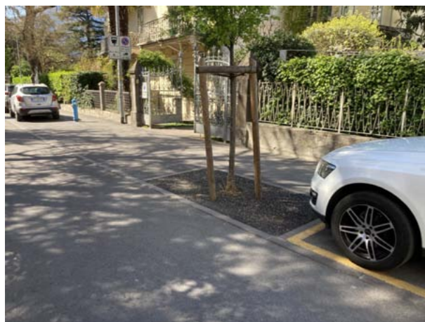
Alberature stradali a Merano dotate di copertura drenante dell'aiuola compatibile con lo stallo di parcheggio
