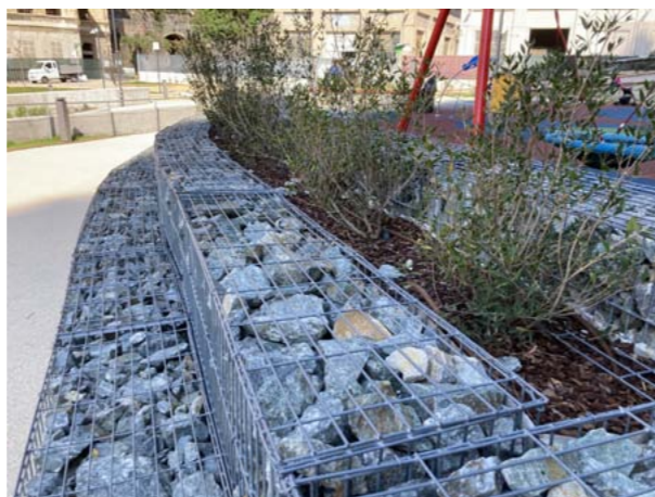
Gabbioni riempiti con pietrame e integrati con filare di arbusti al centro a Genova
